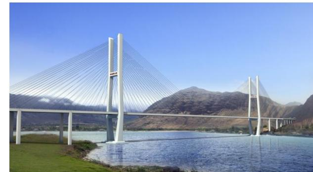
为钢-砼叠合梁，主梁为钢桁梁，面板为预制砼板，共 88 对斜拉索。
