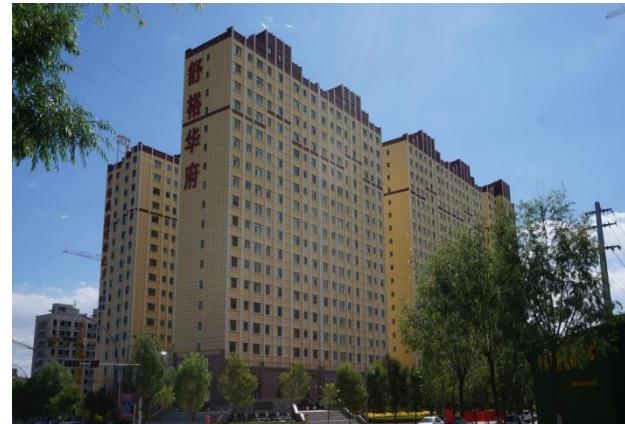
10850.7 平方米，安全等级为二级。2#楼建筑高度 52.95 米，主体结构框剪结构，地下一层；地上 17 层。
