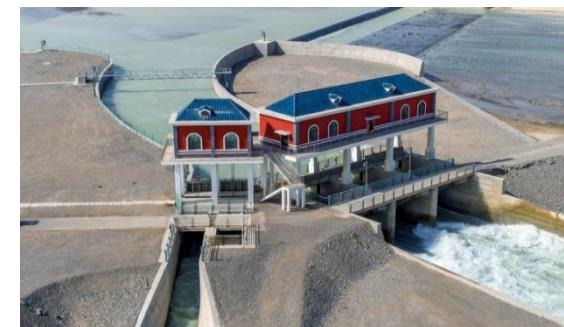
格尔木农场灌区引水枢纽水闸重建工程一标段主要由左右岸堤防、溢流堰（左岸）、引水弯道左右挡墙、东西干渠进水闸、泄冲闸等建筑物组成。
