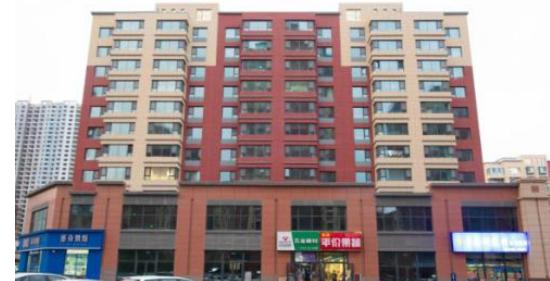
6543.59 平方米，建筑高度 34.95 米，设计室内外高差为 0.45 米，共 11 层，1 至 2 层为商铺，3 层以上为住宅，剪力墙结构。是一个环境优美，基础设施完善的高档商住楼。工程于 2017 年 3 月 15 日开工建设，2018 年 12 月 4 日竣工验收，并于 2019 年 4 月 9 日完成竣工备案。消防、节能、环评、防雷等专项验收均已通过。工程地基最后百天沉降速率已达 -0.03mm~-
