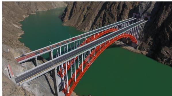
3622.4 米），桥隧比为 98.3%，工程符合青海省“江河源杯”优质工程奖申报条件。路线经河南岸的公伯峡山脊（设公伯峡隧道）、古什群山岭（设古什群隧道、古什群中桥）、公伯岭（设公伯岭 1#隧道、公伯岭 1#大桥）后沿黄河库区南岸前行（设公伯岭 2#、3#大桥、公伯岭 2#隧道），经拱拜寺穿中吾山（设中吾隧道、中吾大桥）后再跨腾喜尖巴黄河支沟进入钦生岭（设钦生岭隧道），出钦生岭隧道后跨越黄河（设主跨 220 米钢管混凝土拱桥），进入黄河北岸后再穿越苏龙珠山脊（设苏龙珠隧道），出苏龙珠隧道后沿黄河北岸继续前行（设哇加滩 1、2 号大桥），到达本项目的终点并与在建的牙同（牙什尕至同仁）高速公路哇加滩枢纽互通相接，合同工期为 2014.3.10-2018.6.30，实际 2017.10.8 通车，2017.12.20 交工验收。
