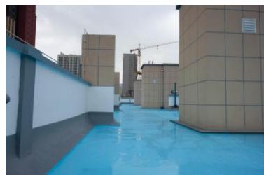
性聚苯板燃烧性能检测合格。商铺外墙保温采用装饰保温一体板（热固性改性聚苯板），外墙保温板排版顺畅，胶缝饱满均匀，做工细腻，大角挺拔竖直，排水口设置合
