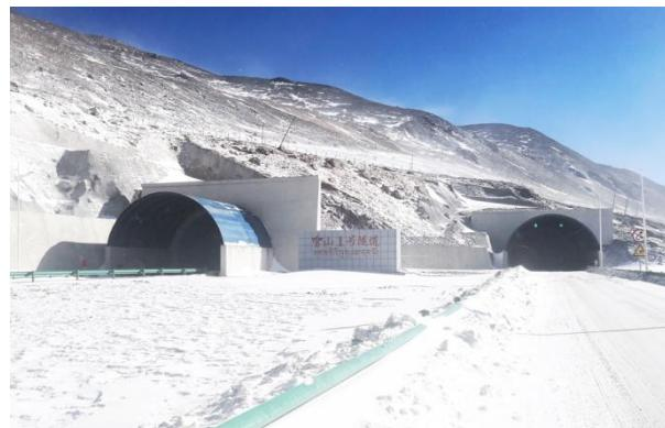
ZK63+010/K58+505 ~ K63+000。隧道限宽 10.25m，限高 5m，抗震防裂度为 IX 度，纵坡为 0.4~2.5% 的人字坡。整个隧道设置 15 个人行横洞，7 个车行横洞，1 个变电所横洞。
