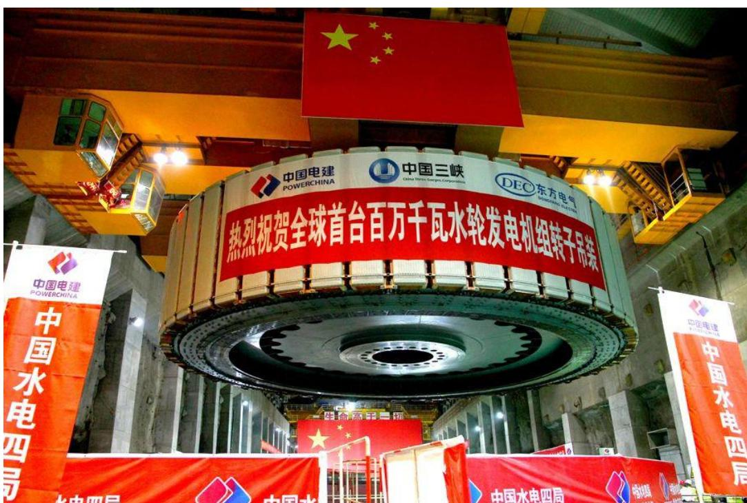
据了解，转子为水轮发电机的转动部件，也是机组的核心部件之一。白鹤滩水电站 1 号机转子主要由转子中心体、扇形支臂、磁轭、磁极和附件组成，直径 16.198 米、最大高度 3.826 米、重 1955 吨，起吊总重 2100 余吨。
