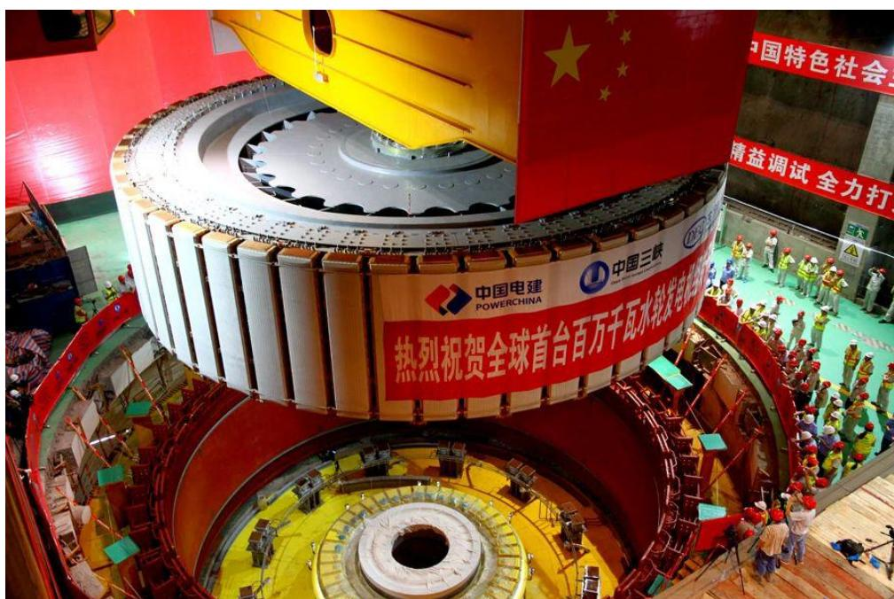
自 2019 年 10 月 1 日首台机组拉开安装序幕，现场施工高潮迭起，定子叠片、定子下线、转轮吊装、转子中心体焊接、磁轭叠装、磁极挂装等重要节点均提前完成，在保证安全管控“双零”的前提下，不仅创造了定子下线 60 天完成世界最快新纪录，而且整体安装工期缩短 2 个月，树立了百万千万机组安装进度世界“新标杆”。7 月 30 日 1 号机定子整体耐压试验一次性通过，8 月 5 日 1 号机转子一次性通过整体耐压试验，具备吊装条件。期间，各项数据显示，安装各工序质量控制均超过设计规范，达到“精品机组”要求，同时创下转子大型结构件圆柱度 0.49 毫米高精度控制世界纪录，确立了百万千万机组安装质量世界“新高度”。
