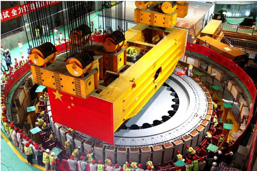
白鹤滩水电站位于金沙江下游四川省宁南县和云南省巧家县境内，是金沙江下游河段梯级开发的第二级电站，为目前全球在建规模最大的水电站，是开发和治理长江上游的重要水电工程，国家能源战略布局“西电东送”的骨干电源点，也是长江防洪体系的重要组成部分。电站左右两岸分别安装 8 台单机 100 万千瓦水轮发电机组，总装机容量 1600 万千瓦，整个机电工程在设计、制造、安装等领域全部实现国产化。中国水电四局承担左岸 8 台机组安装调试任务。工程计划 2021 年 7 月实现首批机组发电目标，2022 年底全部投产，目前各项工作进展顺利。
